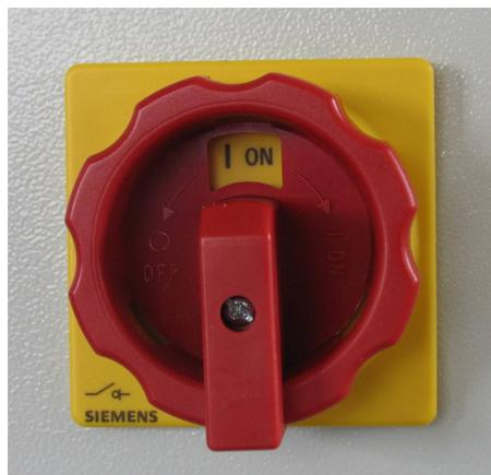
Der Haupt- und Not-Ausschalter befindet sich auf der Türe oder der linken Seite des Schaltschranks. Mit ihm werden alle Funktionen abgeschaltet.
